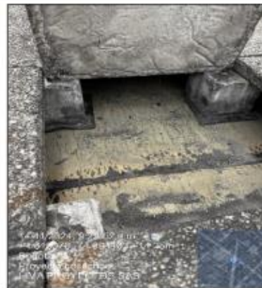
Fotografía 2. Sistema de recolección de agua lluvia piso contrapuesto en terrazas.
