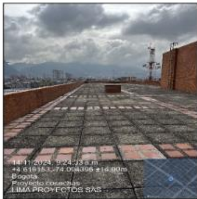
Fotografía 1. Sistema de piso contrapuesto en terrazas de los edificios.
